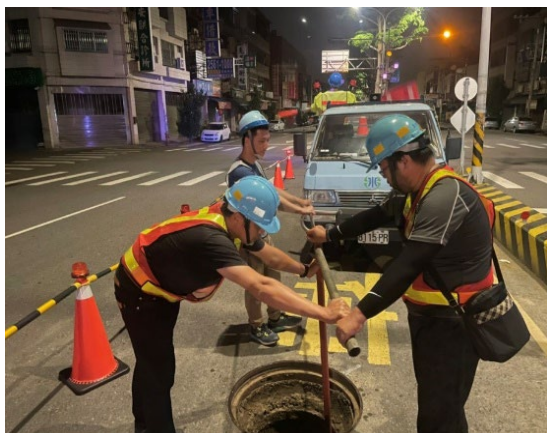
圖 7 台中地區分區供水管網操作
