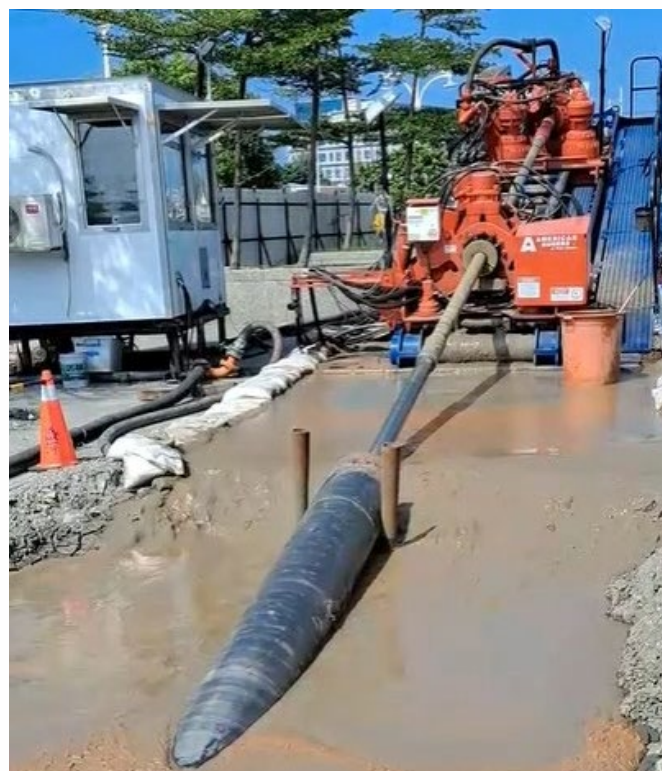
圖 5 旗津區第二條過港送水管水平導向鑽掘作業
