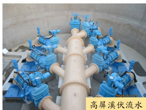
圖 3 伏流水取水及淨水設備
