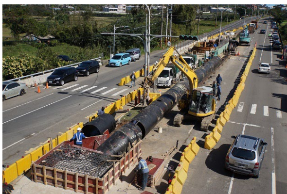
圖 5 桃竹備援幹管管(六)施工情形
