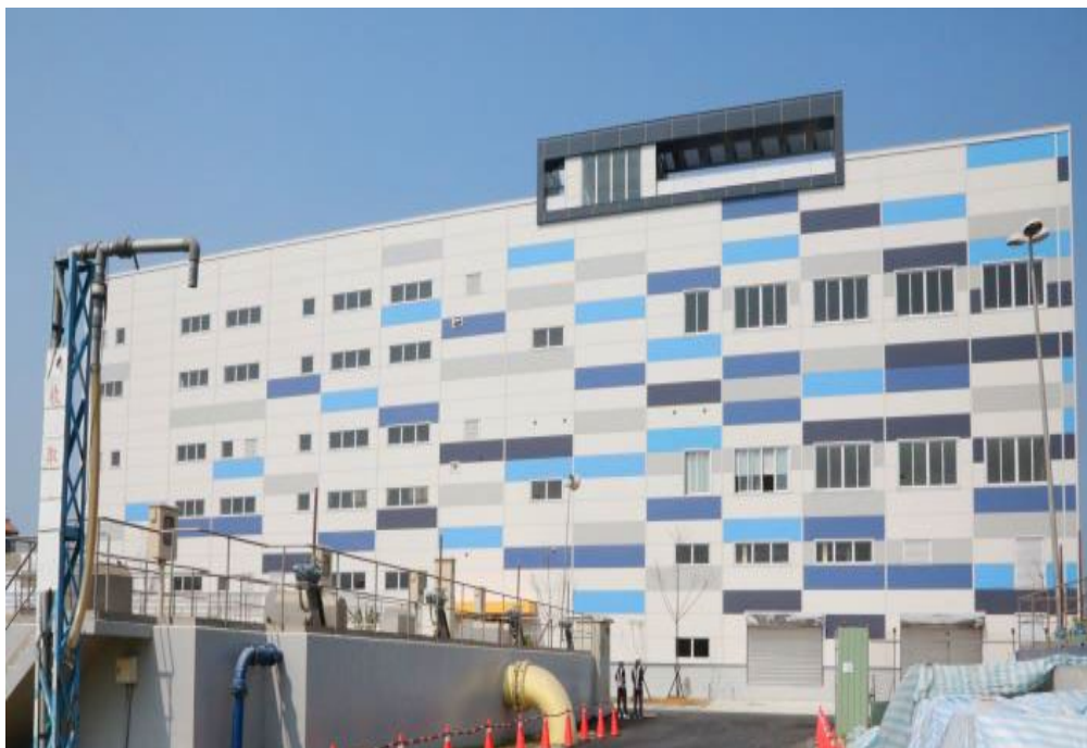
圖 8、臺南安平再生水廠
