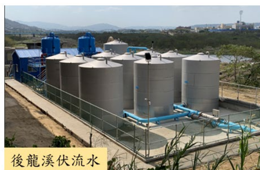
圖 3 伏流水取水及淨水設備
