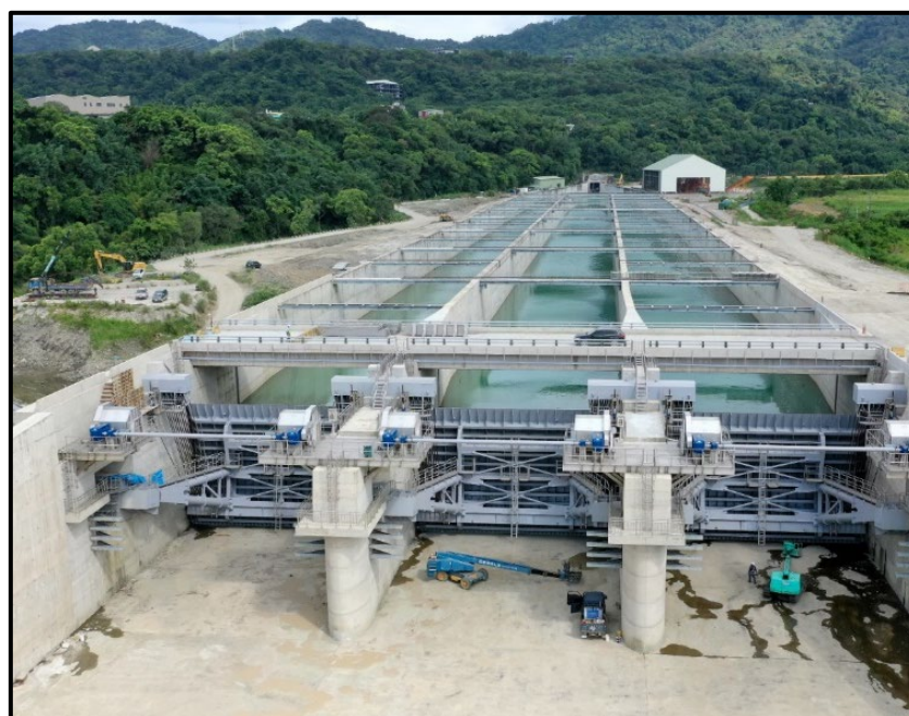
圖 12 沖淤池弧型閘門蓄淤現況
