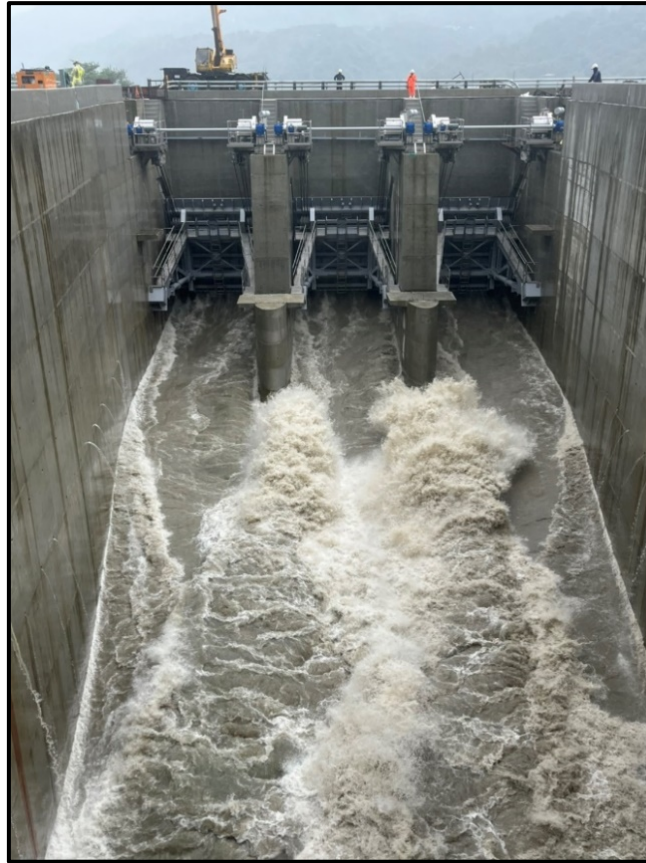
圖15-1 進水口閘門放流
