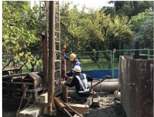
圖 6 水井施工直度測試作業
