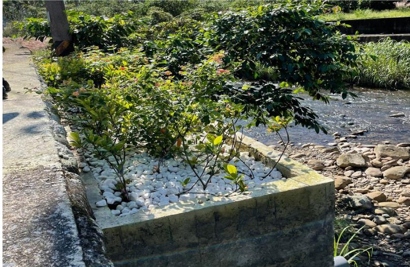
圖10 河階型植生滯留槽
