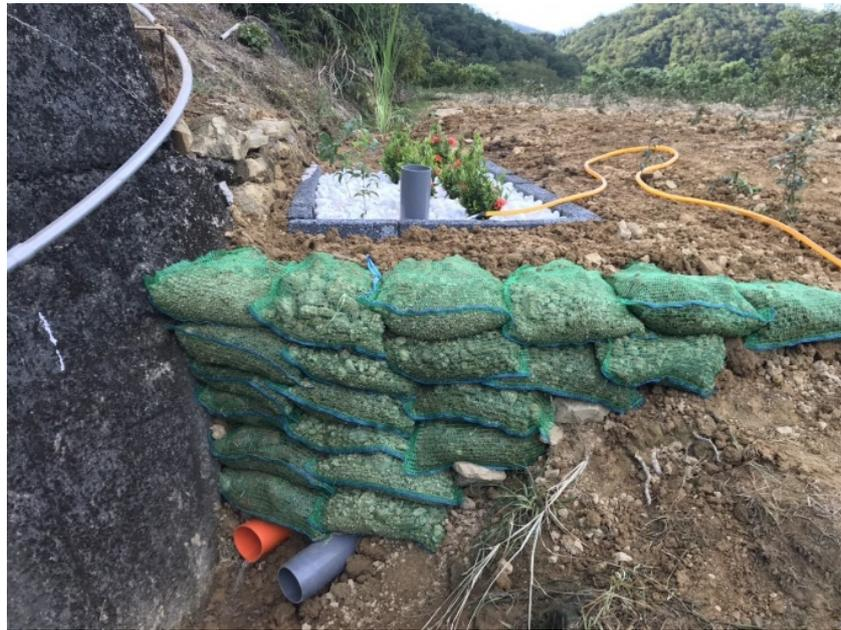
圖8 出流型植生滯留槽
