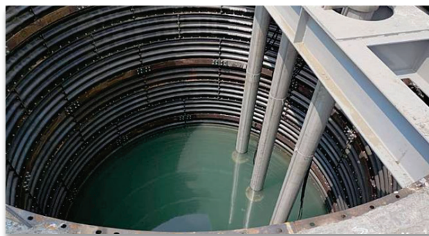
圖5 大安溪伏流水集水井
