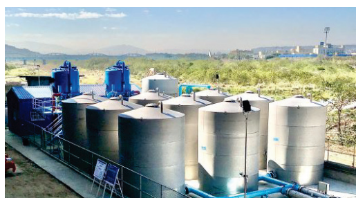
圖 8 後龍溪伏流水緊急取水站建置情形
