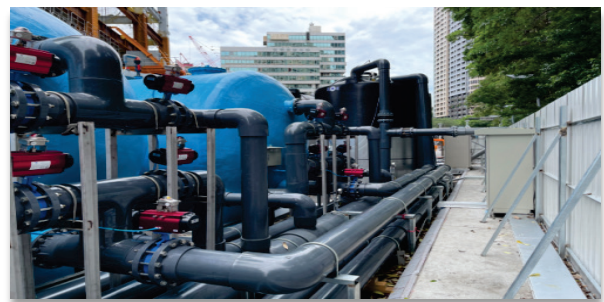
圖3 建築工地地下水利用
