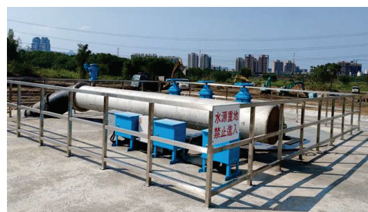
圖 10 烏溪伏流水取水工程建置情形
