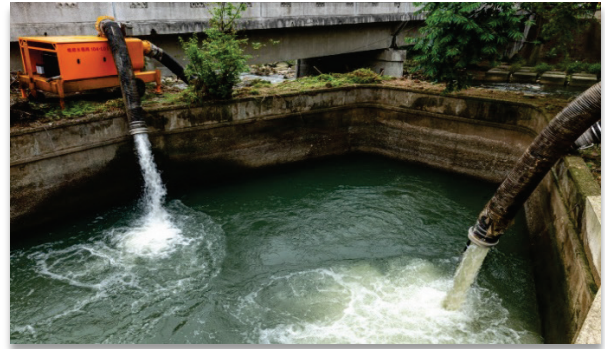
圖2 移動式抽水機支援桃三灌區抽水
