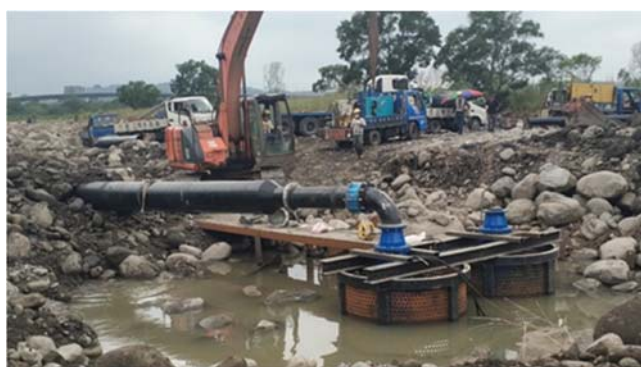
圖14 油羅溪緊急抽水施工照片
