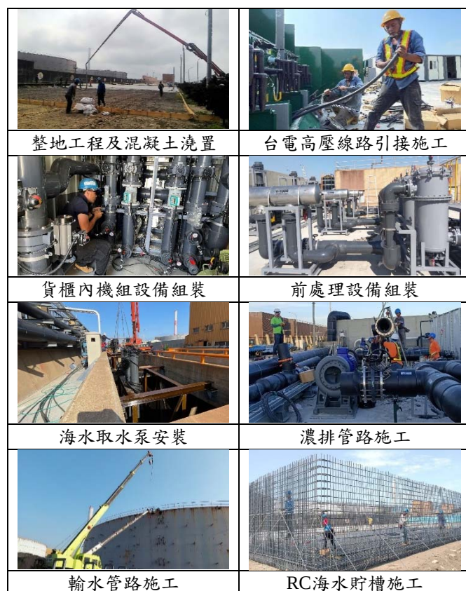
照片2 施工情形照片
