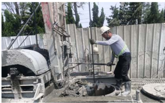
圖4 抗旱鑿井工程施工情形
