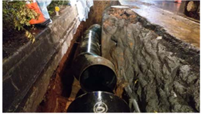
圖6 變更為繞越既有台電人孔
