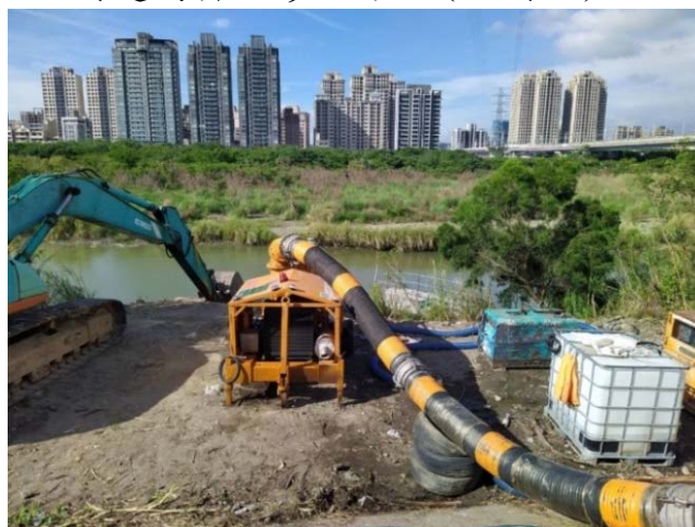
圖15 隆恩堰下游緊急抽水情形
