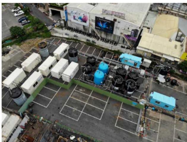
圖8 「勤美之森」工地淨水設備完工圖
