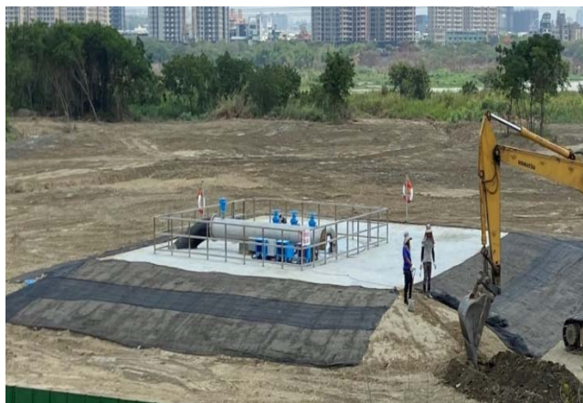
圖12 烏溪伏流水第一期工程完工照
