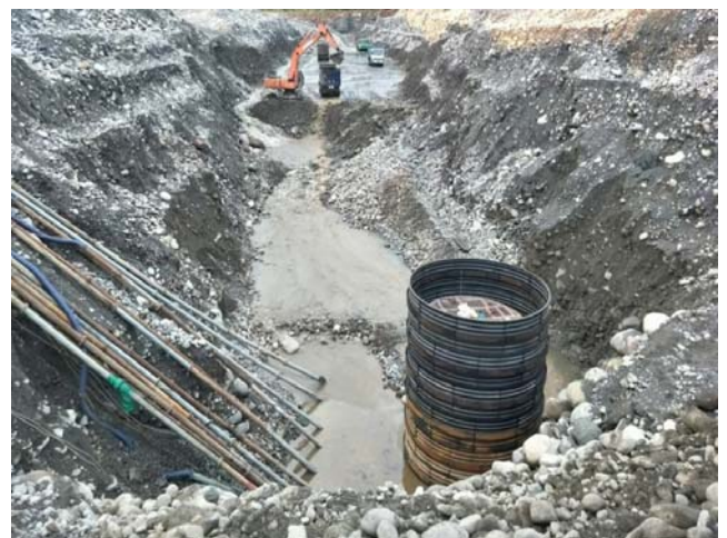
圖5 不銹鋼集水管與集水井施工現況
