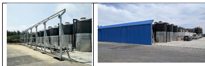
照片4 設置隔音牆照片
