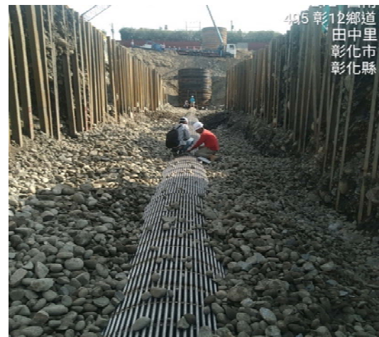
圖11 不銹鋼集水管埋設與濾層回填
