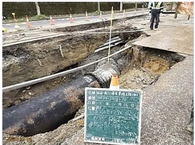
圖7 遇台電管障改埋設至南下側路口
