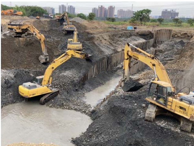
圖9 烏溪第一期工程濾層開挖
