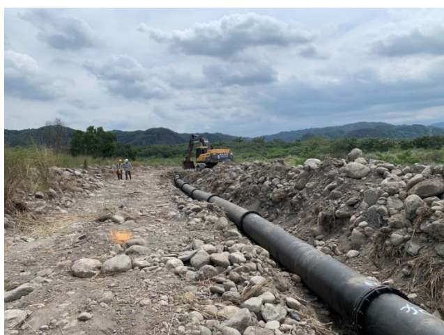
圖20 油羅溪伏流水輸水管線施工現況
