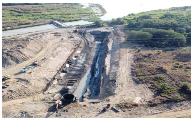
圖15 烏溪第二期工程施工空拍圖
