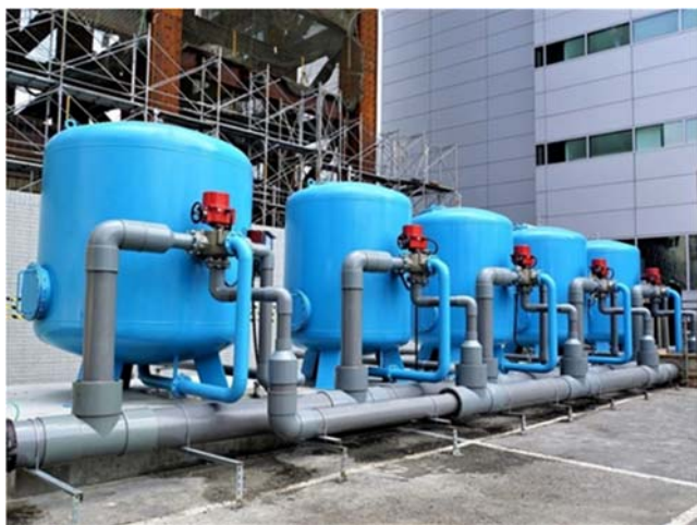
圖19 建築工地地下水利用
