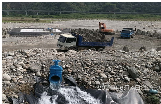
圖7 大安溪伏流水完工後供水現況
