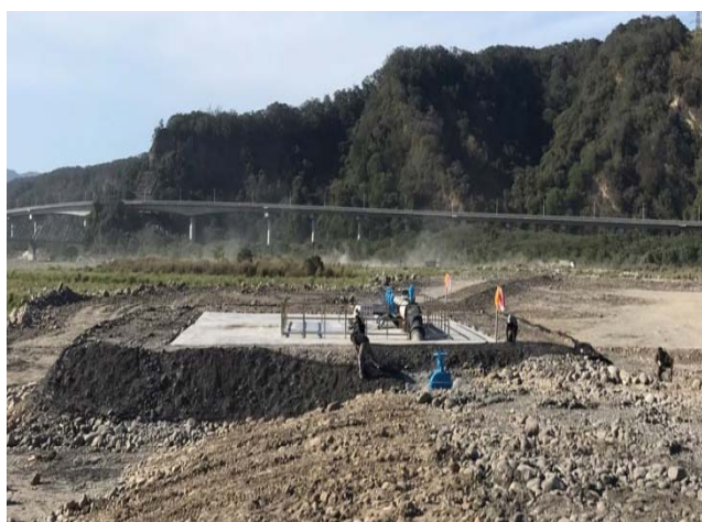
圖6 大安溪伏流水完工後現況
