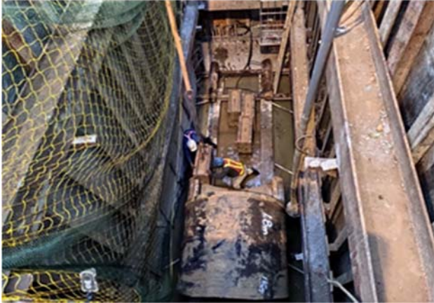
圖4 管(二)-2變更為簡易推進工法
