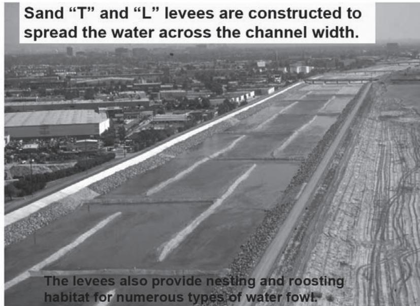
圖 6 加州橘郡河床地下水補注設施照片圖
